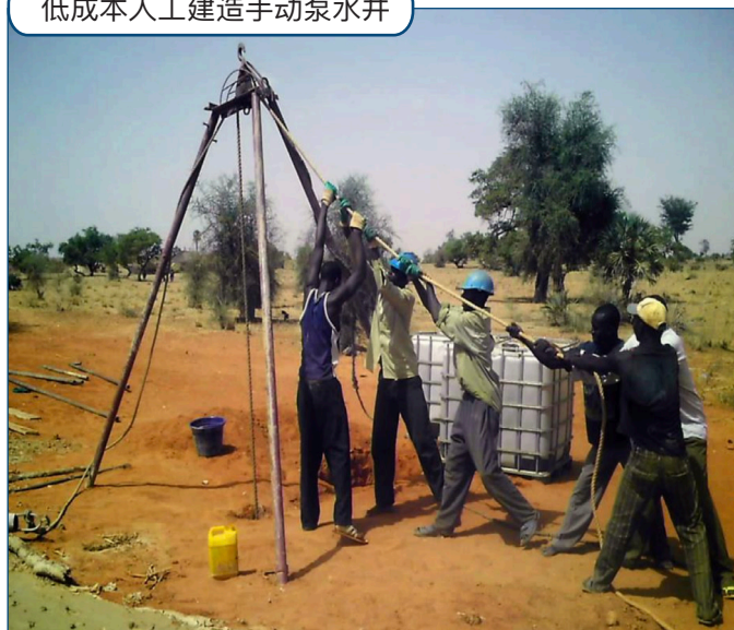
低成本人工建造手动泵水井
