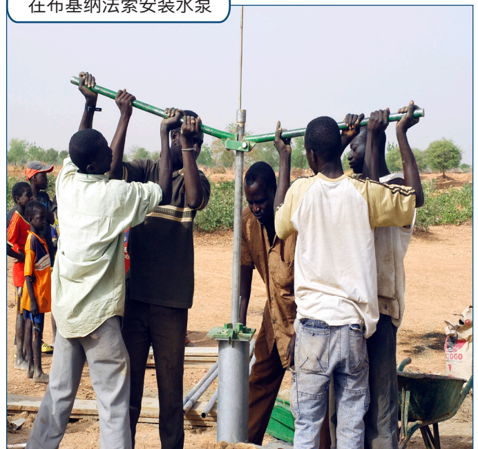
在布基纳法索安装水泵
