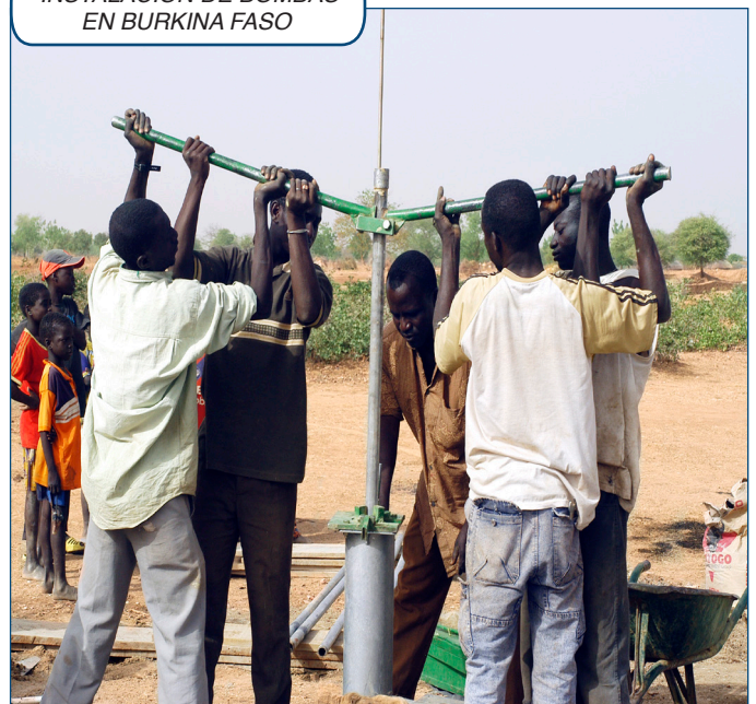
INSTALACIÓN DE BOMBAS EN BURKINA FASO
