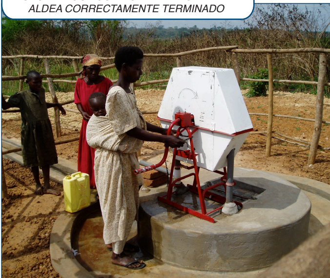
POZO DE AGUA CON BOMBA MANUAL DE LA ALDEA CORRECTAMENTE TERMINADO
