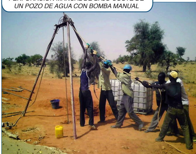
PERFORACIÓN MANUAL DE BAJO COSTE DE UN POZO DE AGUA CON BOMBA MANUAL
