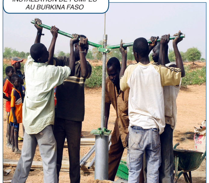
INSTALLATION DE POMPES AU BURKINA FASO
