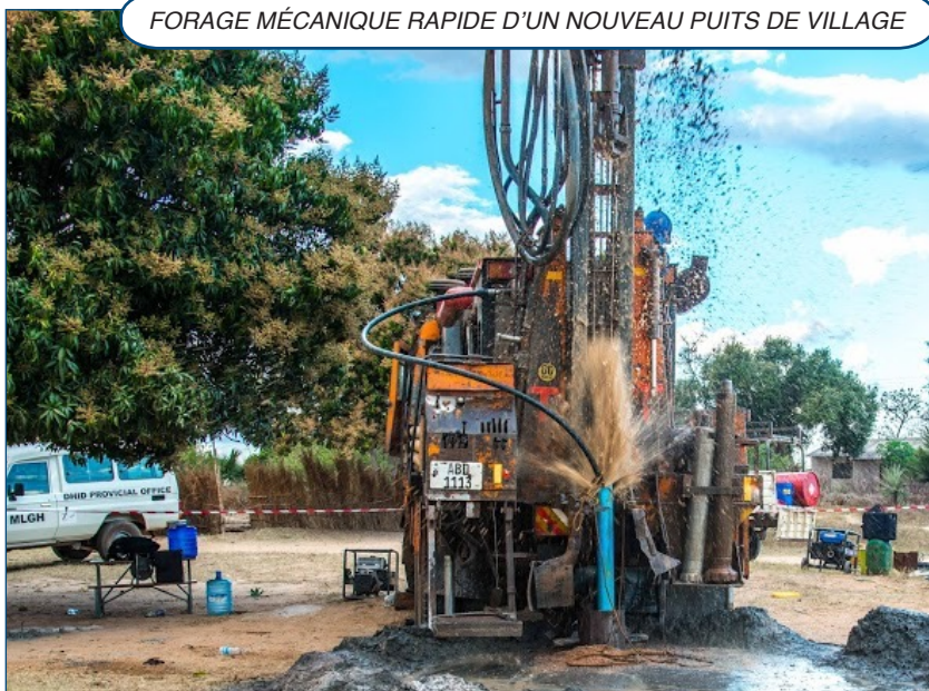
FORAGE MÉCANIQUE RAPIDE D'UN NOUVEAU PUITS DE VILLAGE
