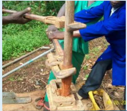
乌干达霍尔马区腐蚀机井升水管的拆除 (来源: Larry Bentley)
